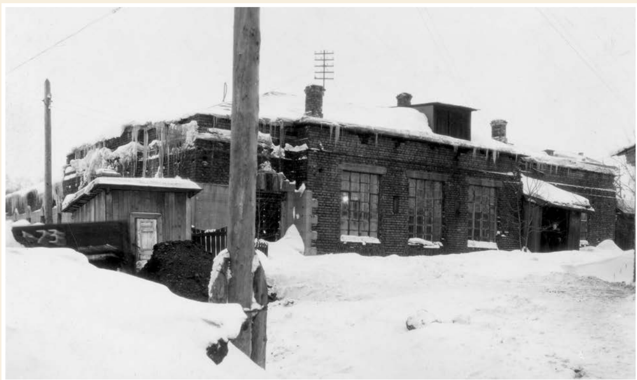
Здание Пермского отделения Свердловского областного архивного управления по адресу Комсомольский проспект, 43. [1930-е гг.]
