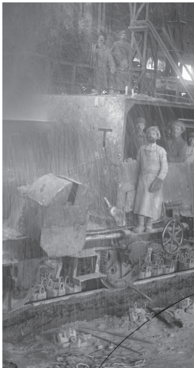
Рабочие Чусовского металлургического завода. 1924 г. Негатив на стекле. ГАПК. Ф. ф-61. Оп. 61 инс. Д. 34.
